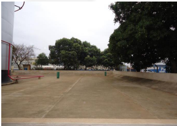
Foto 03. Local de instalação do novo tanque, em local com Bacia de Contenção.
