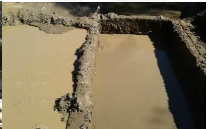
Foto 02. Propriedade Sítio Alegre, poligonal do DNPM nº 833.043/2003, com medidas mitigadoras (bacia de decantação e caixa tri compartimentada) já instaladas.
