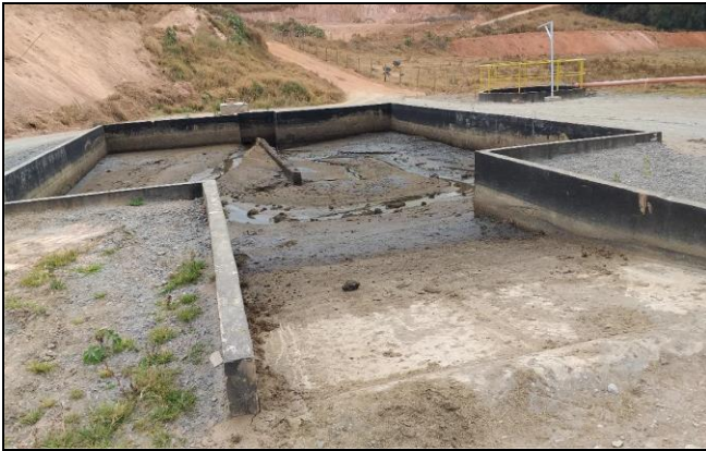
Figura 1: Sistema de tratamento dos efluentes da bovinocultura – retenção de areia.
