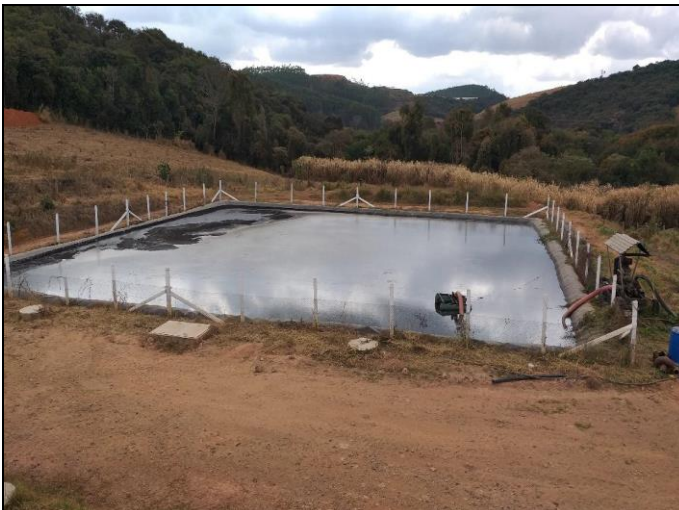
Figura 3: Sistema de tratamento dos efluentes da bovinocultura – lagoa.
