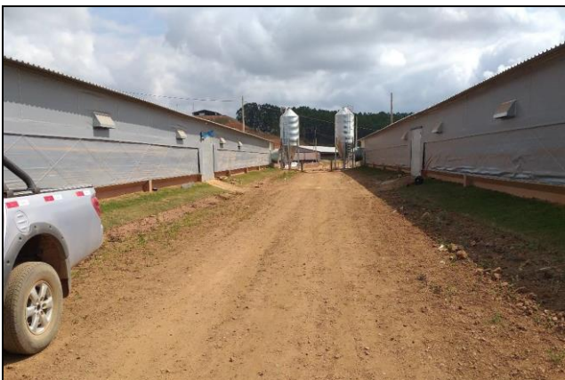
Figura 5: Aviários já instalados. Gramado na projeção do telhado e silos de ração.
