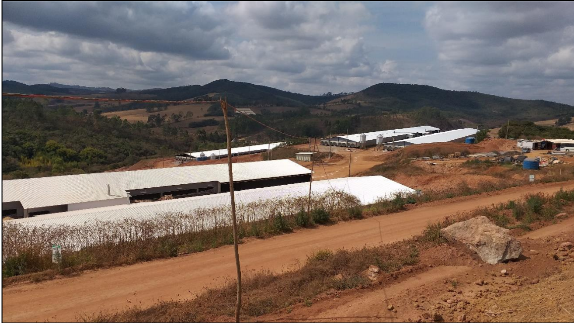
Figura 7: Vista geral dos aviários já construídos.
