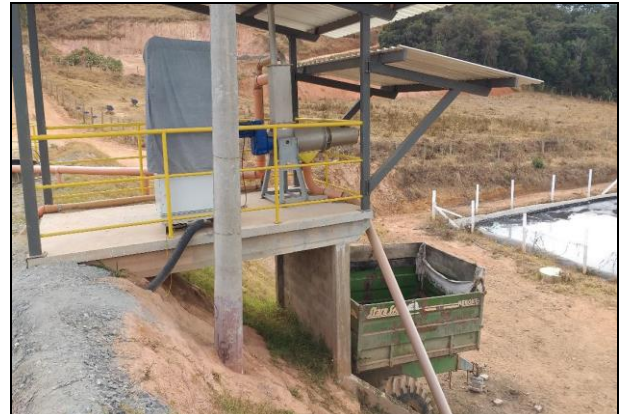
Figura 2: Sistema de tratamento da bovinocultura – separador de sólidos.
