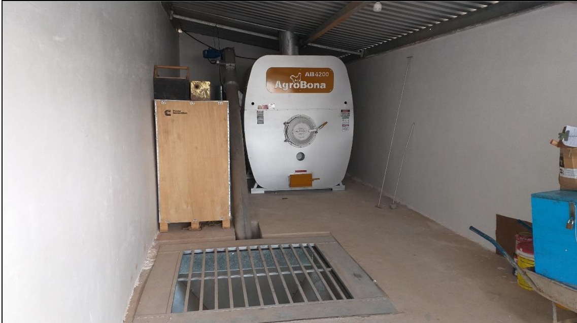
Figura 9: Fornalha automática para o aquecimento do aviário.
