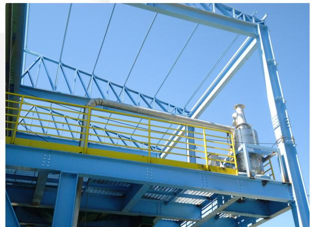
**Foto 04.** Lavador de gases e exaustor instalados
