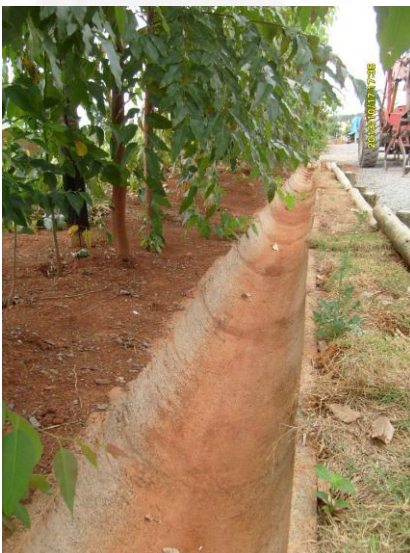
Foto 15: Canaleta para drenagem pluvial.
