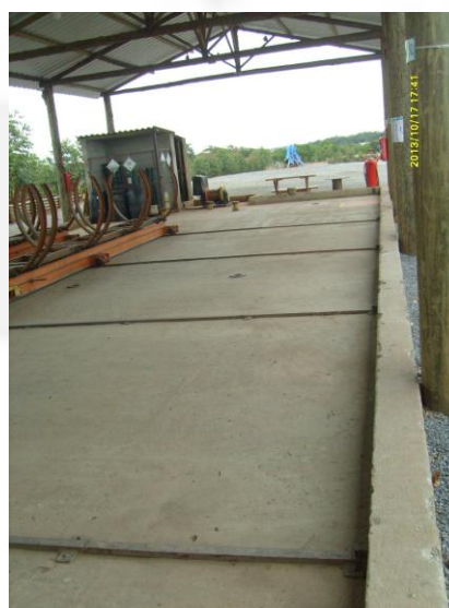
Foto 10: Barreira de contenção do galpão.
