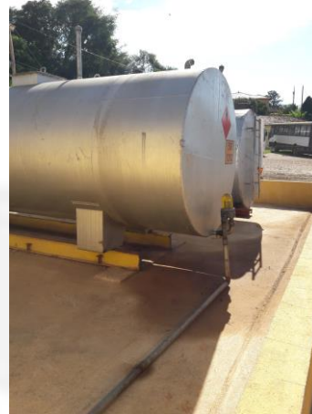
Foto 06. Tanques e bacia de contenção
