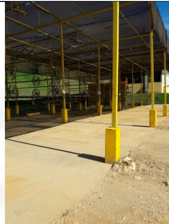
Foto 02. Galpão de recepção de aves
