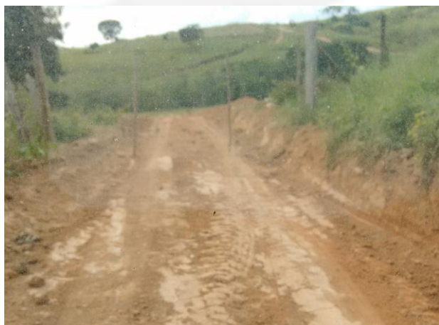
Foto 01. Estrada que dá acesso direto à área da ETE.
