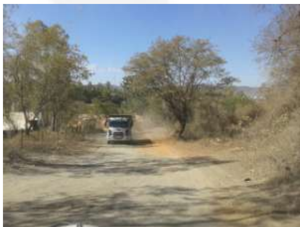
Foto 19: Vias de acesso sem aspersão (20/07/2015).
