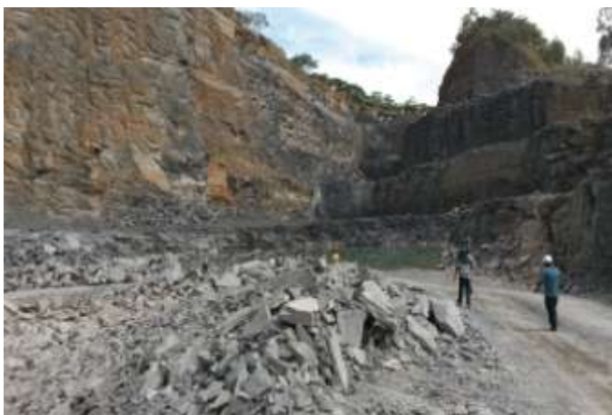
Foto 05. Vista parcial das bancadas sendo instalada na cava. Área atualmente embargada (26/01/2015).
