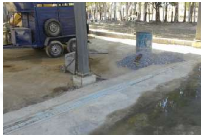
Foto 5. Oficina de veículos e máquinas em obras (20/07/2015).
