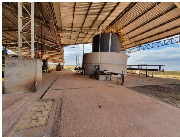
Foto 02. Tanque de armazenamento de Óleo Combustível.
