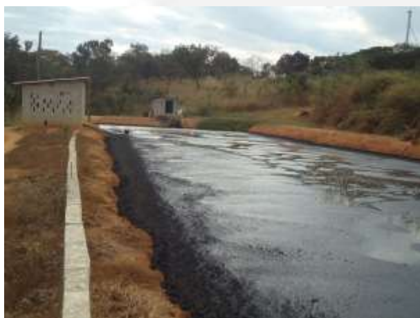
Foto 12. Antiga lagoa após o biodigestor.
