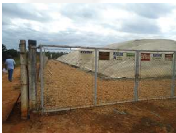
Foto 10. Biodigestor antes da manutenção.
