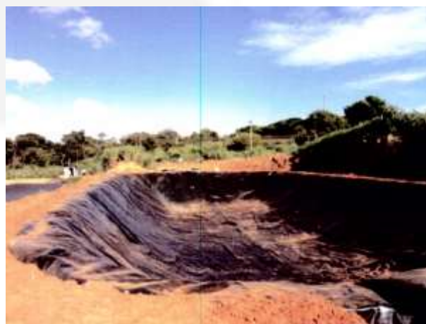
Foto 13. Lagoa construída após o biodigestor, à esquerda esta a antiga lagoa.
