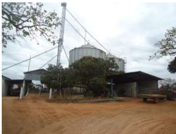
Foto 08. Vista da fábrica de rações com o conjunto silos metálicos.
