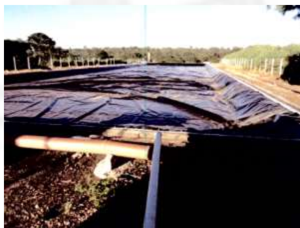
Foto 11. Biodigestor após manutenção.
