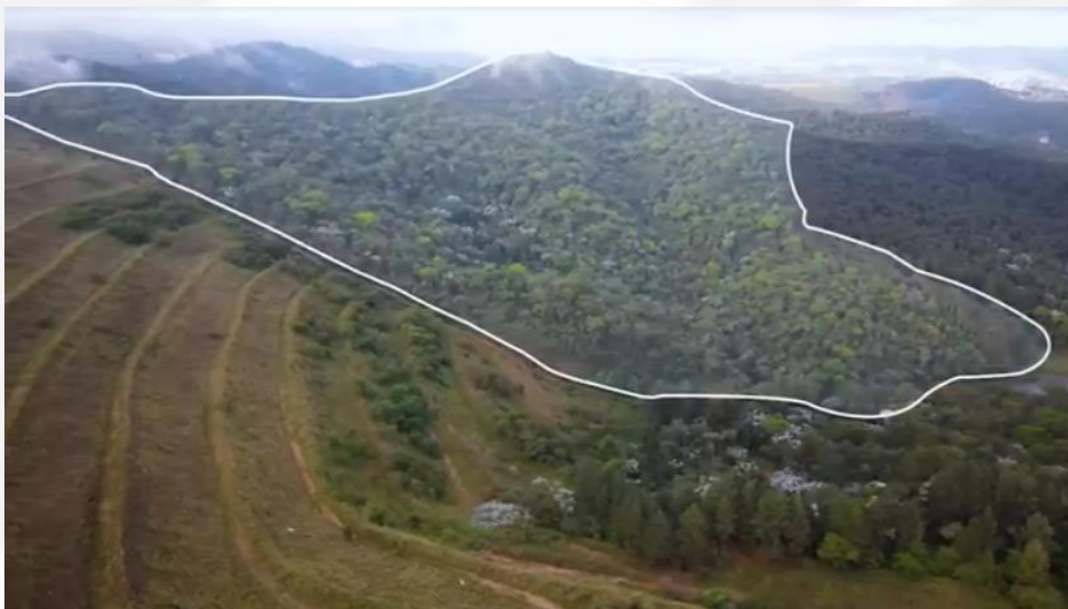
Figura 6: Localização das áreas de FESD em estágio médio em relação à pilha já existente. Fonte: Vistoria Remota, 2020.
