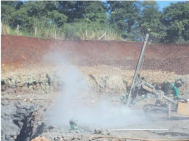
**Figura 6 - Perfuração da Rocha através do Compressor**
