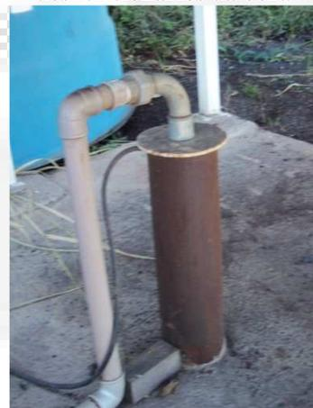
**Figura 11 - Poço tubular**
