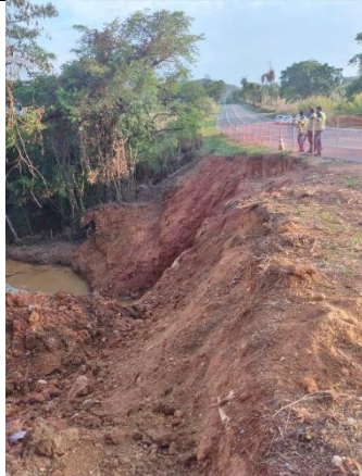
Figura 7 – Obra de recuperação 1
