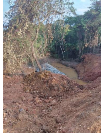
Figura 8 – Obra de recuperação 2
