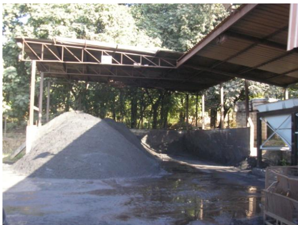
Foto 01. Galpão para armazenamento de matéria-prima.
