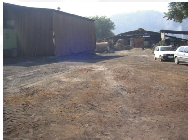
Foto 04. Pátio de trânsito de caminhões.
