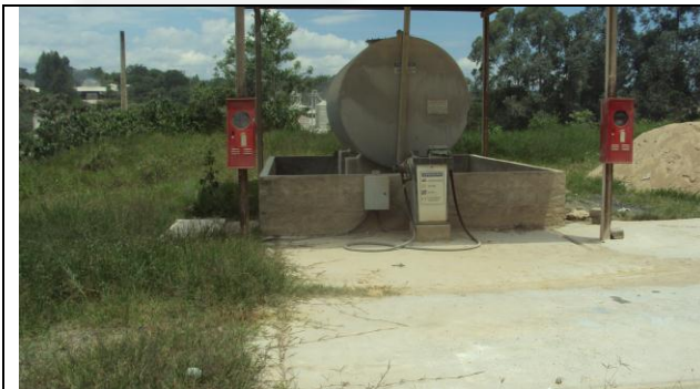
Foto 01. Posto de abastecimento de veículos.
