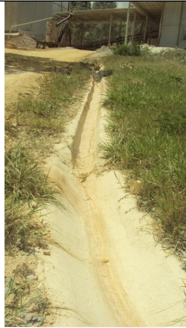
Foto 05. Drenagem pluvial.
