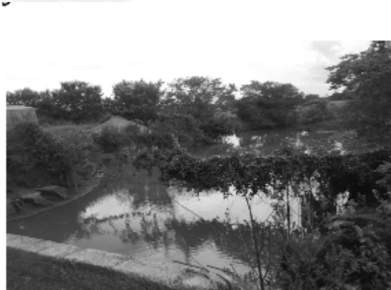
Foto 04. Local de Instalação do barramento
