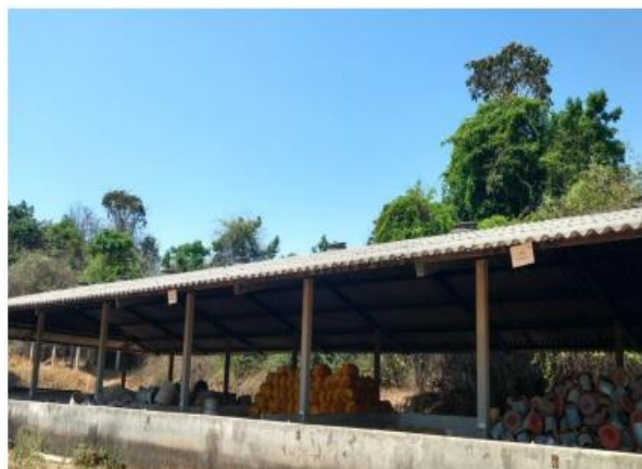
Foto 3: Armazenamento temporário de resíduos
