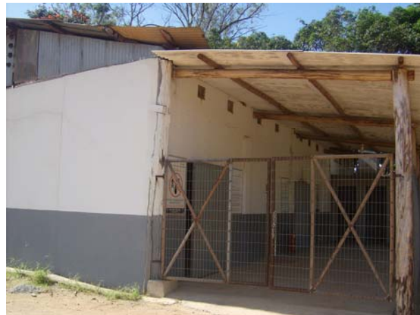
Foto 02. Galpão de armazenamento de produtos fitossanitários.
