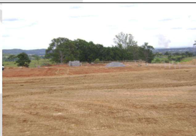
Foto 02. Canteiro de obras
