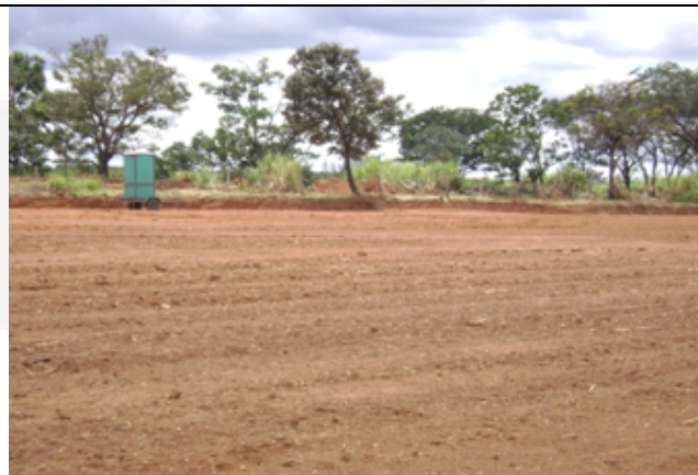
Foto 04. Banheiro químico utilizado no canteiro de obras
