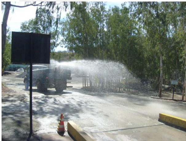
Foto 01. Umectação das vias de acesso
