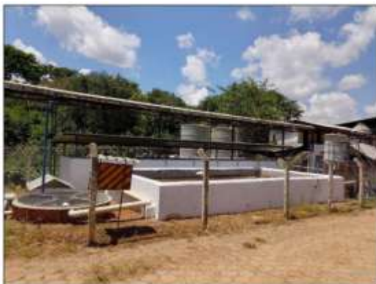
Foto 11. Vista geral da ETE
