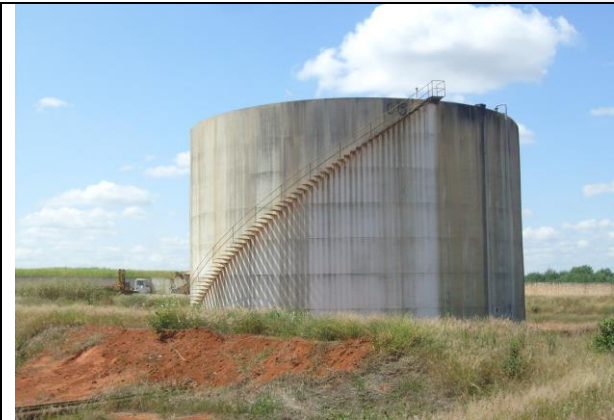
Foto 1: Tanque já existente para armazenamento de álcool.
