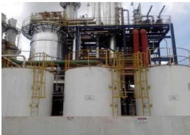
Foto 01. Tanques de armazenamento de óleo fúsel, álcool de segunda e álcool anidro.
