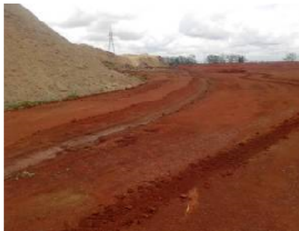
Foto 04. Canal de contenção no depósito de bagaço
