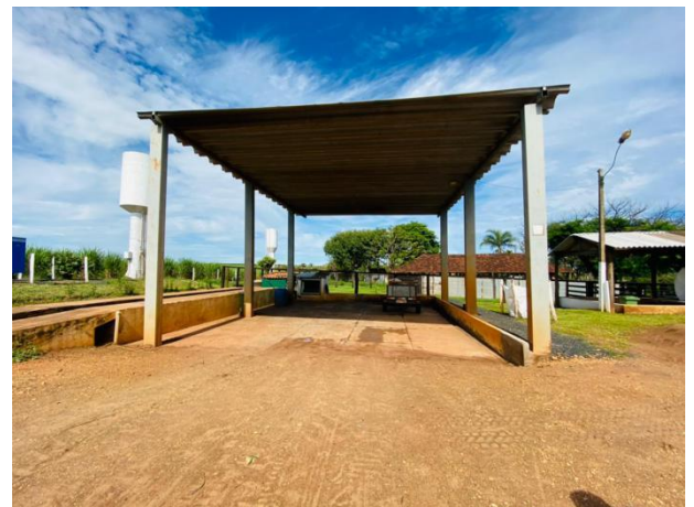
Foto 04. Local para lavagem de maquinário/veículos
