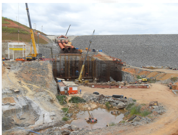
Foto 03. Etapa das obras de implantação da casa de força da PCH Mucuri.
