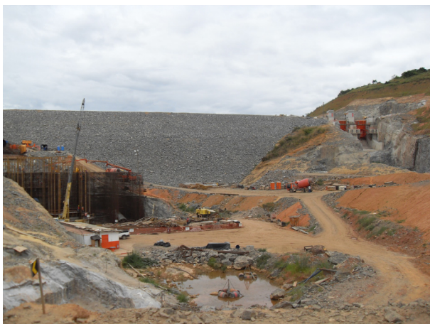
Foto 01. Vista da barragem da PCH Mucuri (foto tirada da enseadeira de jusante).
