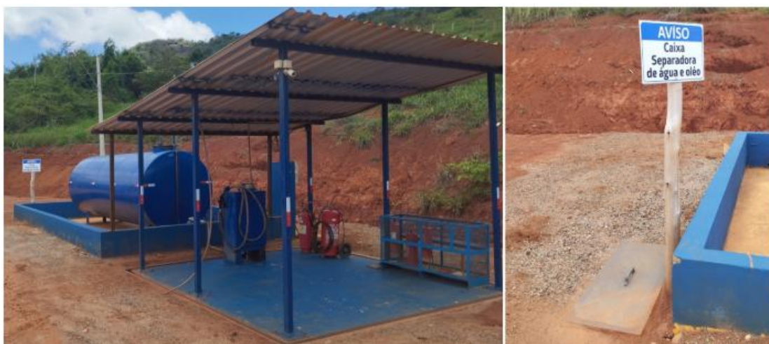
Ponto de abastecimento com canaletas e a respectiva caixa SAO
