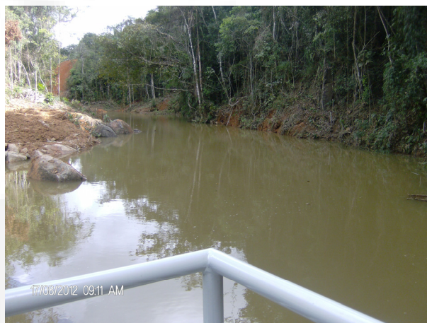
Foto 04. Reservatório formado no ribeirão da Bomba pela implantação da CGH.
