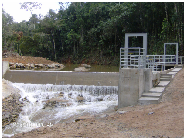
Foto 01. Barragem da CGH no ribeirão da Bomba.
