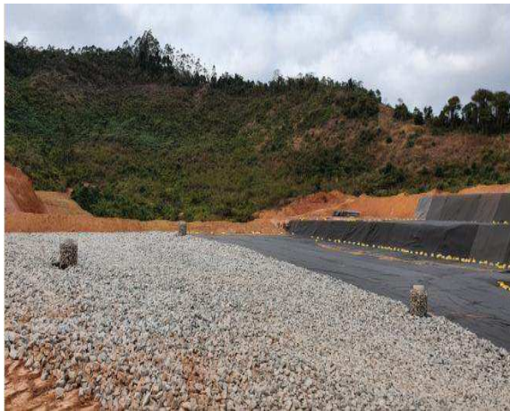
Imagem 1 – Vista da impermeabilização do aterro
