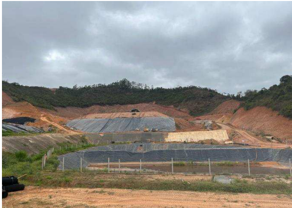
Imagem 3 – Área do aterro devidamente protegida.
