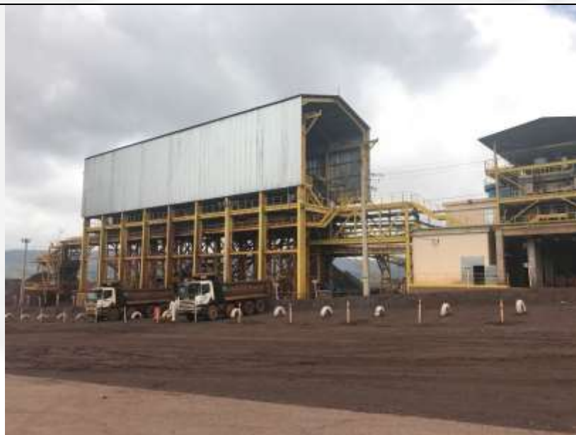
Figura 14 Estrutura de 24 metros de altura implantada para armazenamento dos filtros cerâmicos
