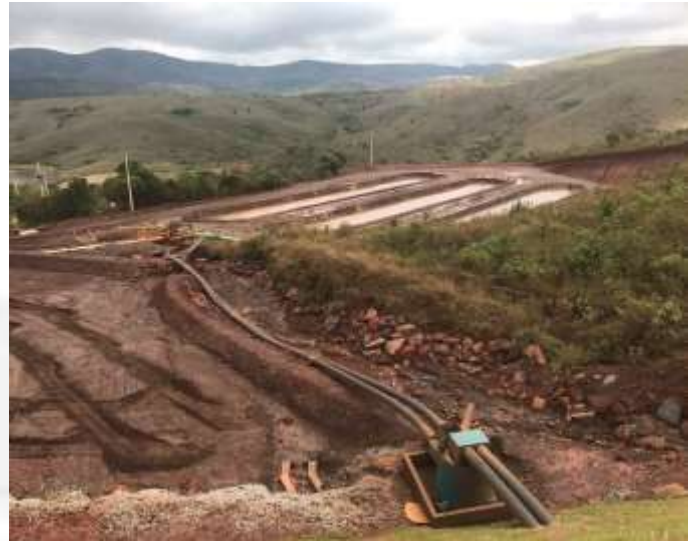
Figura 5 Baias de retomada d'água em operação
