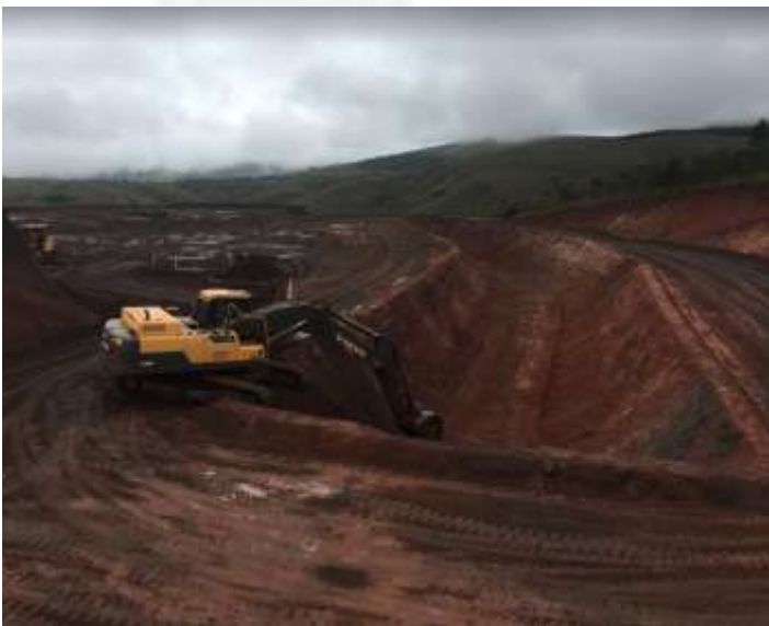
Figura 6 Baía de sedimentação em terreno natural em implantação
