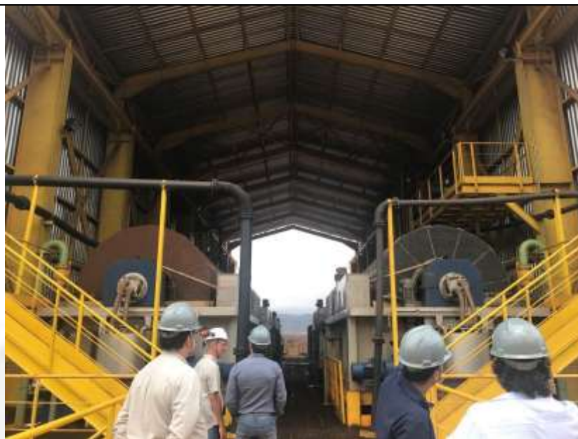
Figura 13 Filtros cerâmicos de secagem em operação no empreendimento
