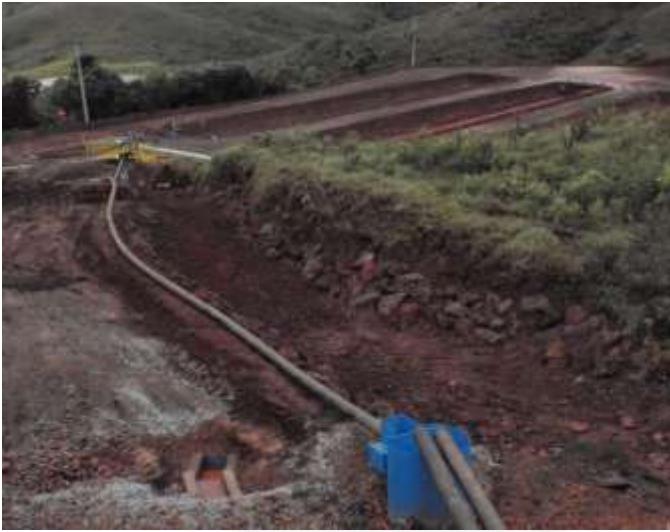
Figura 4 Baias de recuperação d'água em construção
