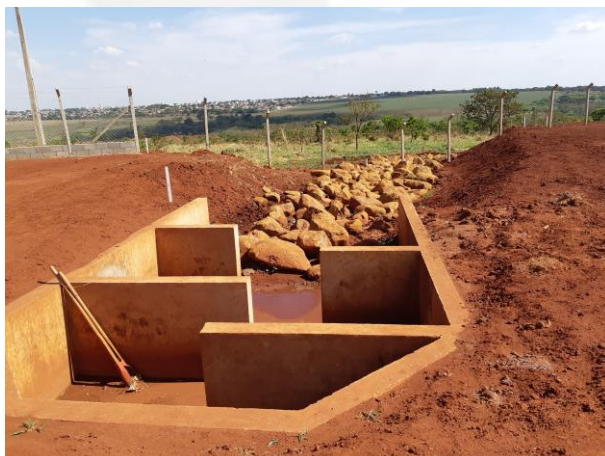
Foto 03. Dissipador de energia seguido por enrocamento
