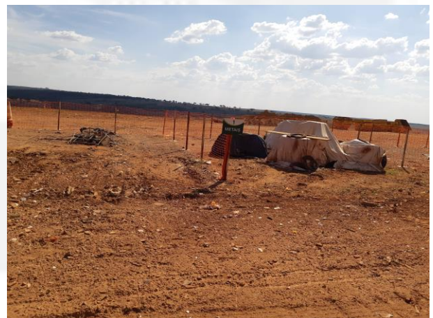
Foto 04. Aterro de RCC/baias identificadas para segregação de resíduos
