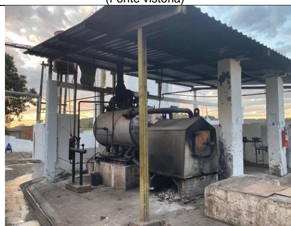
Foto 4 – Caldeira a lenha. (Fonte RCA do processo)
