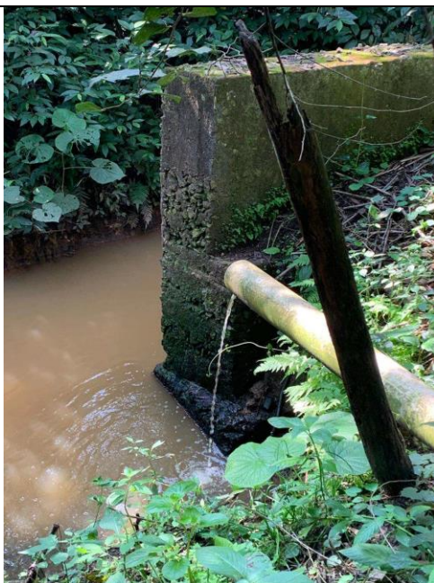
Foto 7 – Lançamento do efluente tratado no Córrego Morro Grande. (Fonte: RCA do Processo)
