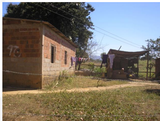
Foto 04. Residências que terão que ser relocadas.
