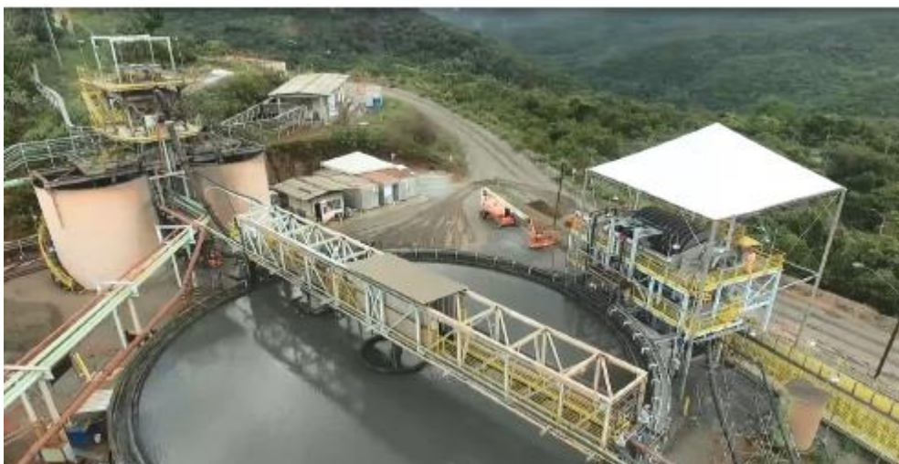
Figura 2: Planta de Filtragem e Desaguamento já implantado e em operação na mina Cuiabá. Fonte: EIA, 2020.
