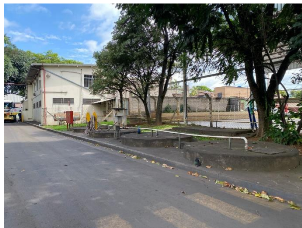
Foto 02. Tanques de armazenamento de água pluvial
