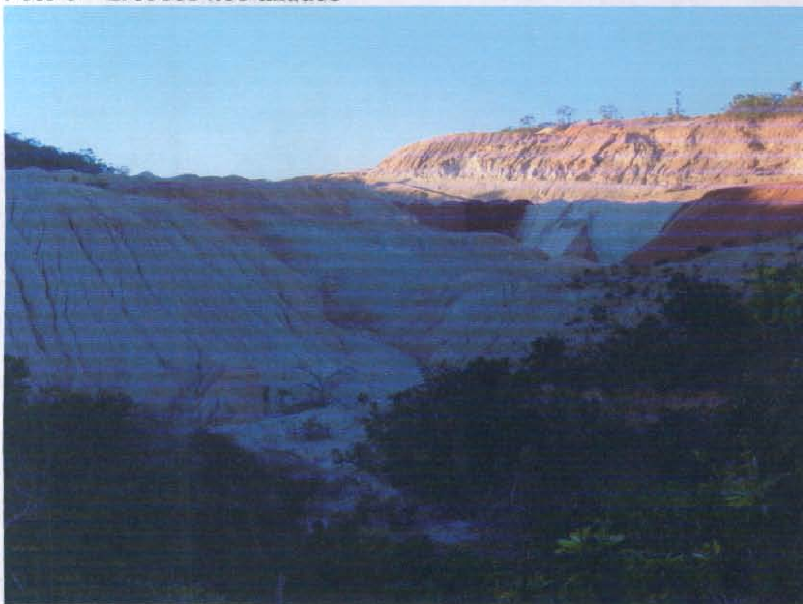
Foto 6 – Erosões nos taludes
