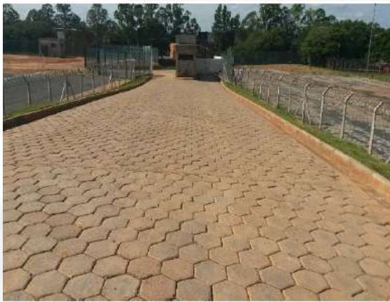
Foto 15 – Cercamento do Terreno
