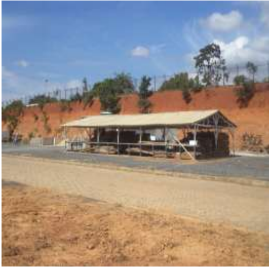
Foto 07 – Localização do canteiro de obras
