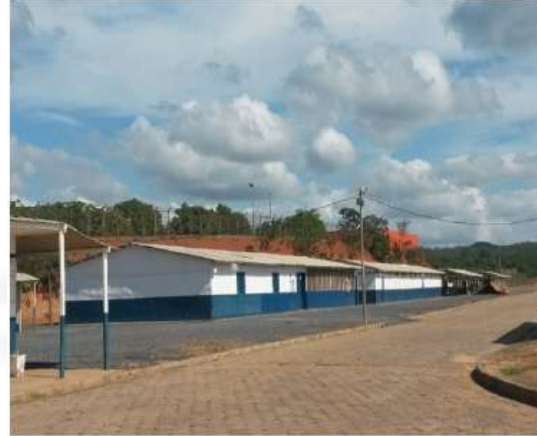
Foto 10 – Canteiro de obras
