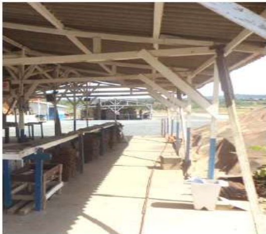
Foto 11 – Canteiro de obras
