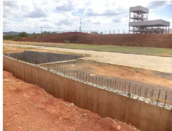
Foto 16 – Muro de arrimo das docas
