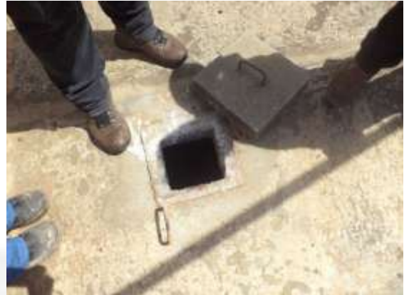
Foto 14 – Fossa seca desativada
