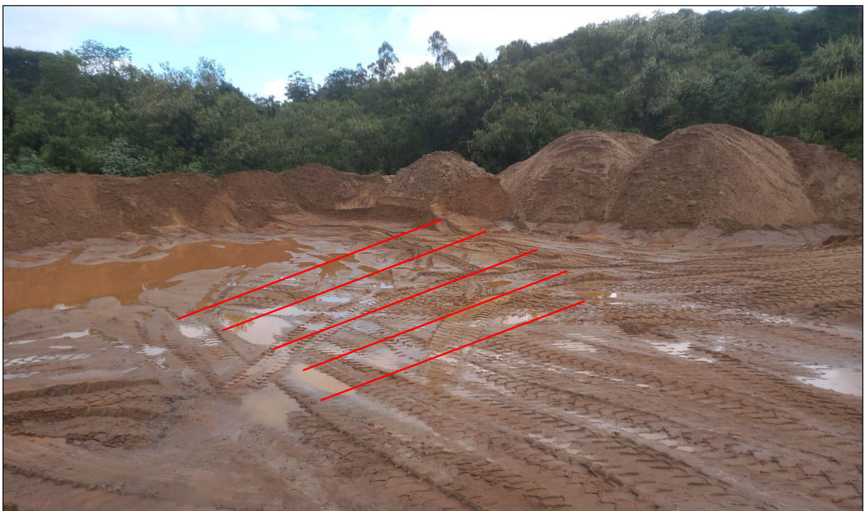
Figura 09: Inclinações direcionando as águas pluviais e efluente líquido oriundo da umidade do produto disposto em solo, até a bacia de decantação de sólidos.
