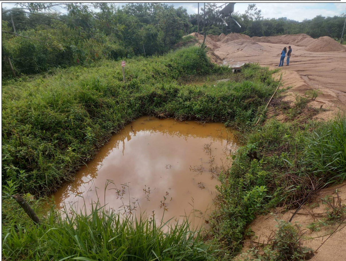
Figura 10: Bacia de decantação de sólidos bicompatimentada.
