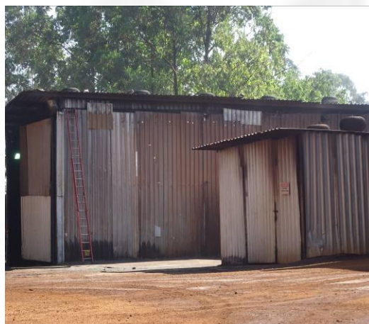
Foto 04. Galpão enclausurado para descarga de carvão vegetal.
