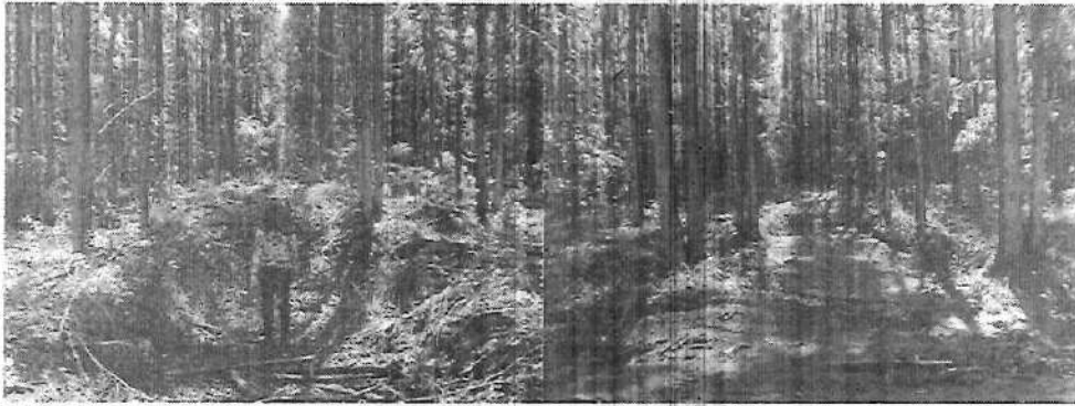
Foto 1: Cacimbas para infiltração da água pluvial na Fazenda Canta Galo, estas são encontradas por toda a fazenda. Em (a) seca com a pessoa para servir de referencial do tamanho e em (b) cheia para a infiltração da água pluvial.
