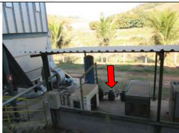
Foto 8. Processo de tratamento da purga dos compressores (seta vermelha).
