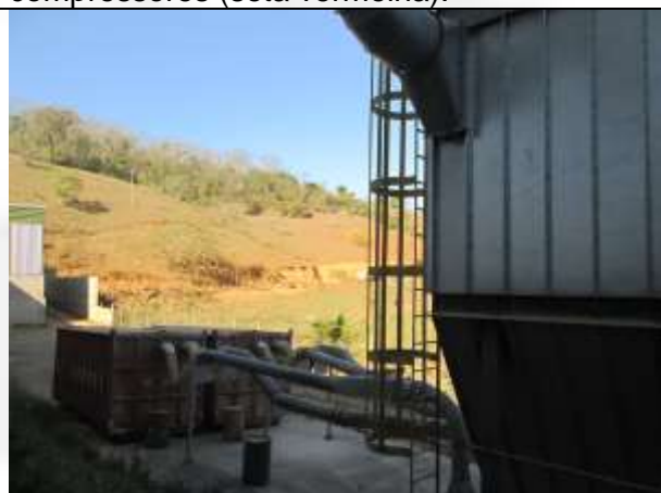
Foto 10. Armazenamento do pó de madeira.
