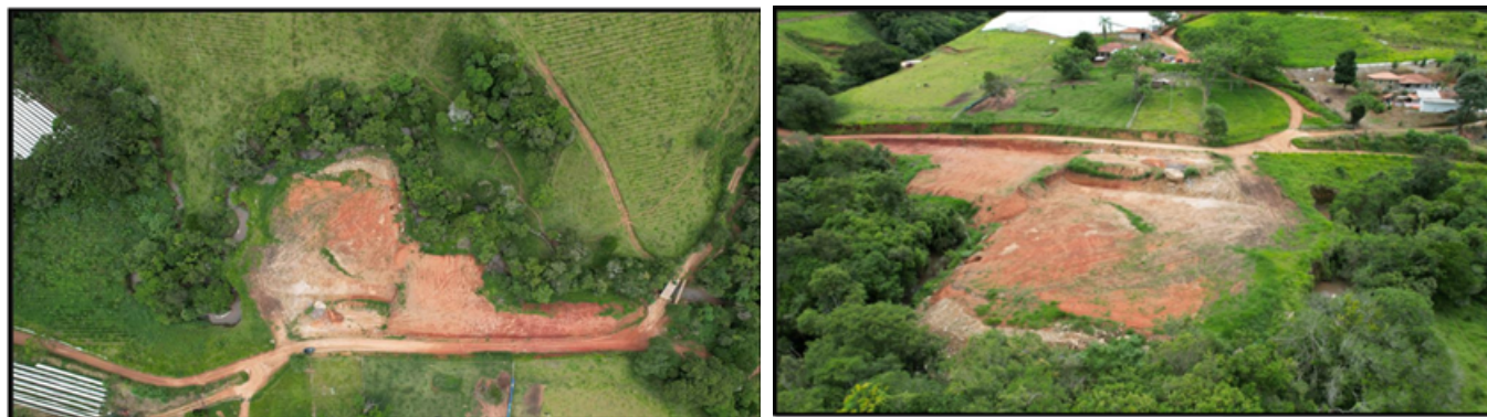
Imagens 3 e 4 - Área da intervenção em app realizada através de terraplanagem.
