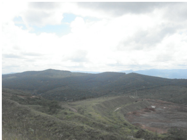
Foto 01. Área a ser instalada a PDE Pedreira Borrachudo.
