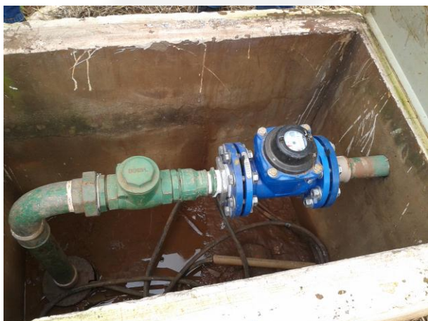
Foto 15 e 16. Poço tubular com Hidrômetro e horímetro
