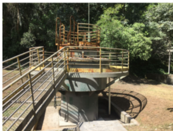
Foto 06. Reator anaeróbio de fluxo ascendente - RAFA
