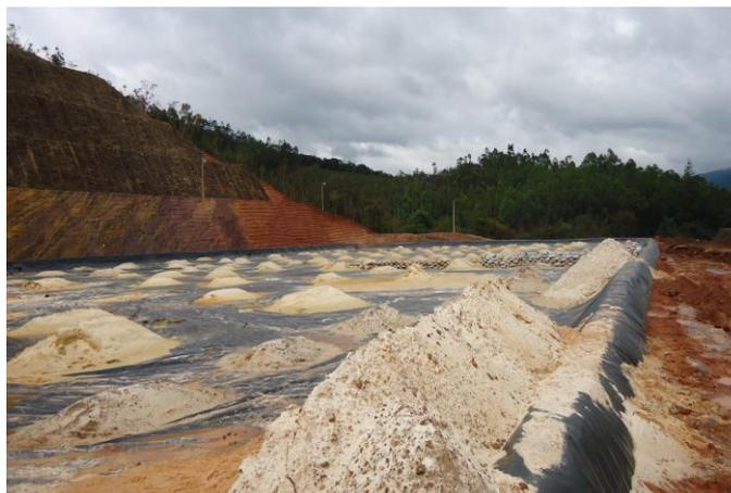
**Foto 11.** Base da Pilha de lixiviação (UTM).
