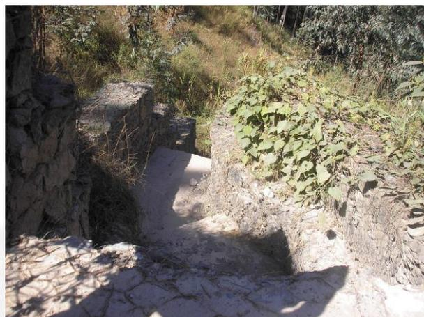
**Foto 06.** Enrocamento em pedra de mão argamassada na base do dique.
