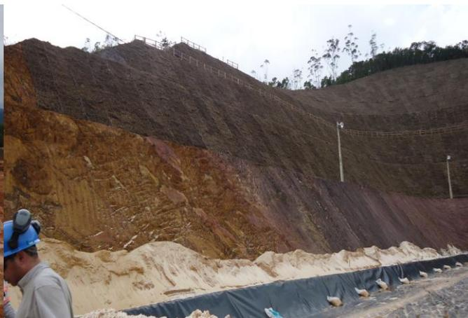
**Foto 12.** Taludes em recuperação na área de instalação da pilha de lixiviação (UTM).
