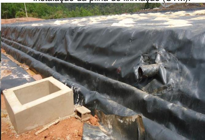
**Foto 14.** Vista lateral da Pilha de lixiviação (UTM) detalhe para os pontos de saída e drenagem do lixiviado.
