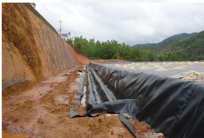
**Foto 13.** Vista lateral da Pilha de lixiviação (UTM) detalhe para os pontos de saída e drenagem do lixiviado.
