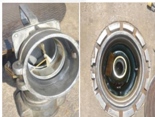
Figura 02: Sistema de Descarga Selada
