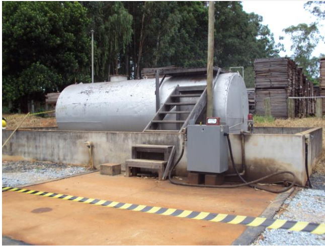
Foto 05. Posto de abastecimento
