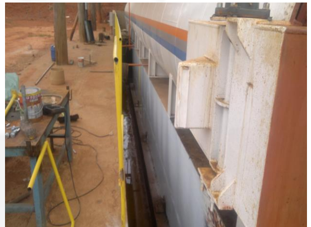
Foto 04. Autoclave com canaletas para recirculação do efluente
