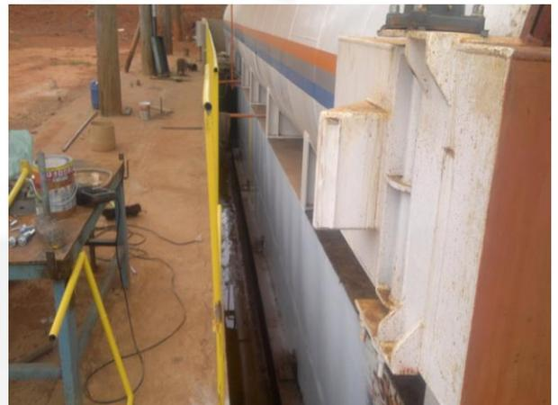
**Foto 04.** Autoclave com canaletas para recirculação do efluente
