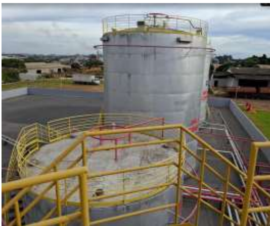
Tanques com válvulas de alívio de gases
