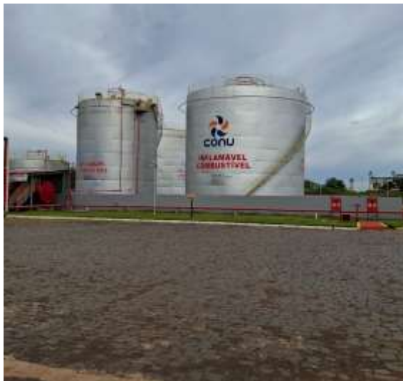
Tanques com bacias de contenção
