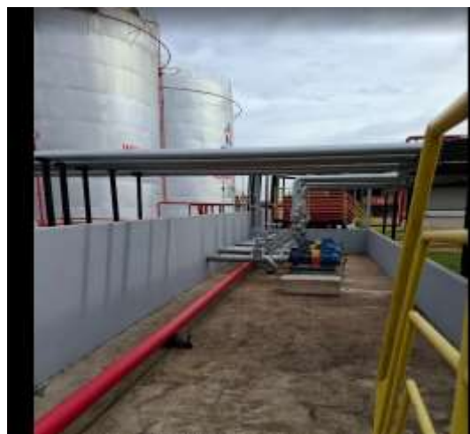
Conexões sobre bacia de contenção
