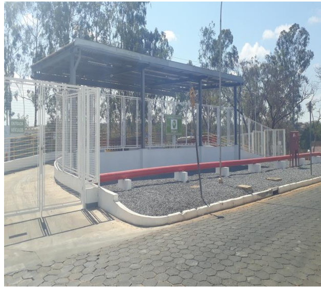
Foto 4 – Entrada do depósito temporário de resíduos
