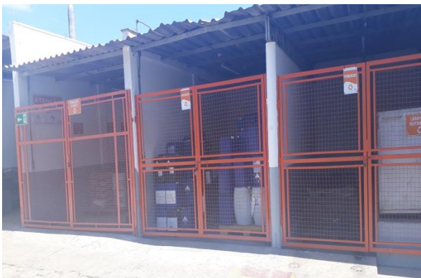
Foto 5 – Depósito temporário de produtos perigosos
