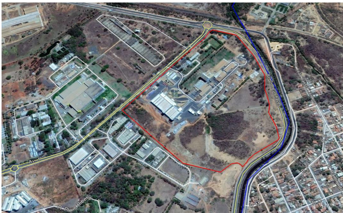
Figura 1 – Área total dos empreendimentos da Nestlé – Fonte: RADA.
