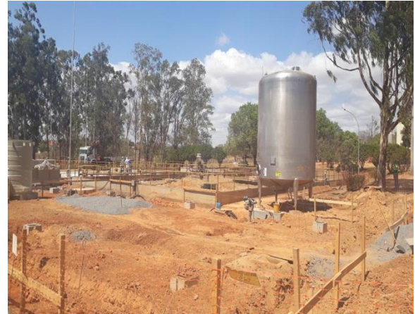
Foto 10 – PTAR em operação e em modificação
