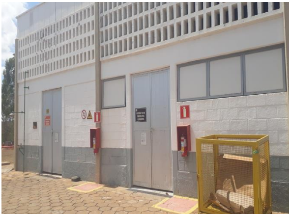
Foto 11 – Depósito de produtos químicos
