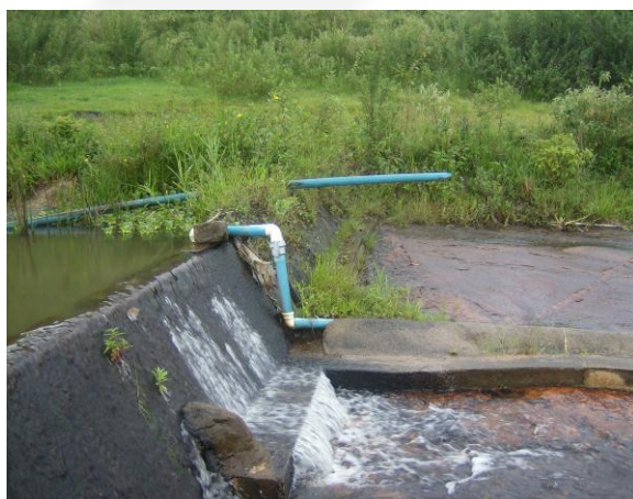
Foto 03. Barramento utilizado para captação de água.
