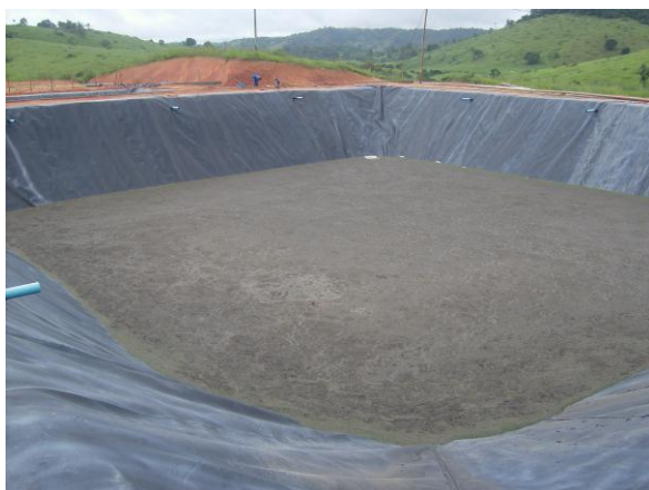
Foto 01. Lagoa de tratamento de efluentes – tratamento biológico secundário.
