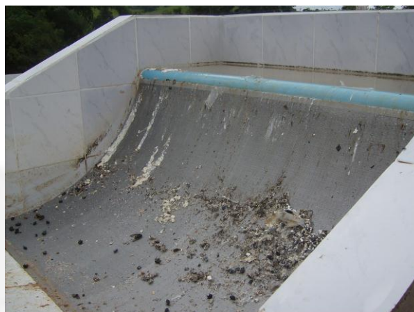
Foto 02. Peneira para retenção de sólidos grosseiros – tratamento primário.
